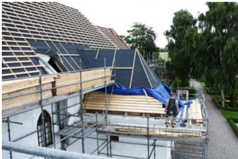
Figur 8.1 Fast undertag med afstandslister under lægtning
