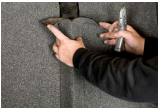
Figur 8.1.1.15: Tilskæring af kappe.
