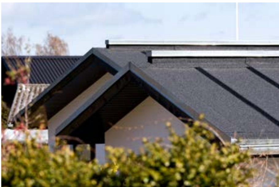
Figur 3.2.7: Kipventilation med zinkrygning.
