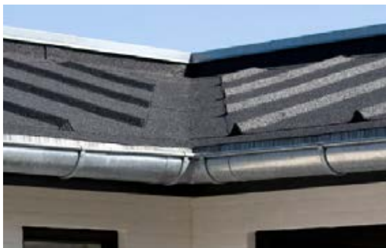
Figur 2.4.2: Skotrende mellem 2 tagflader med listedækning.
