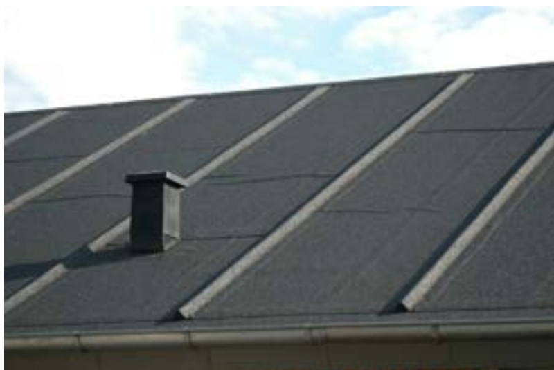
Figur 6.2.1: Eksempel på overpap med uacceptable folder.
