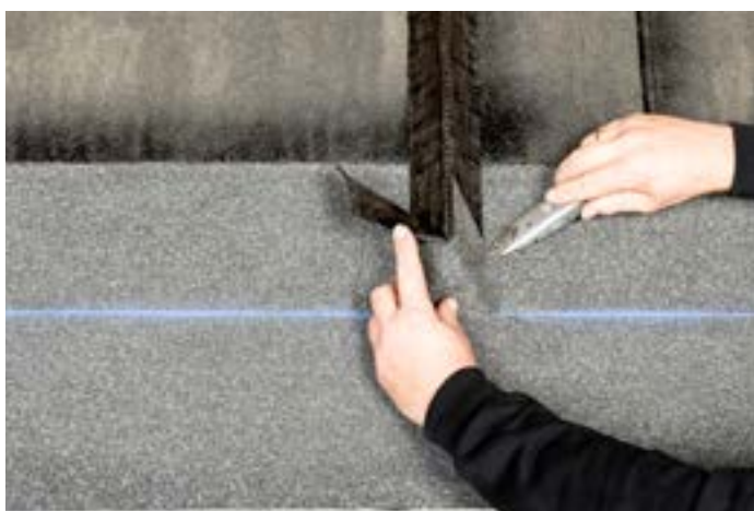
Figur 8.1.1.6: Endestykke tilskæres.
