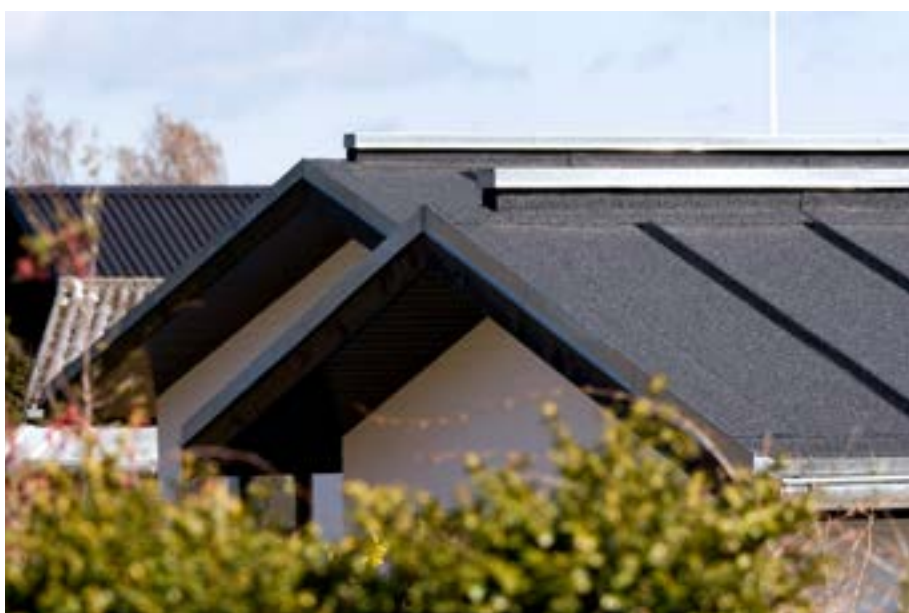
Figur 3.2.7: Kipventilation med zinkrygning.
