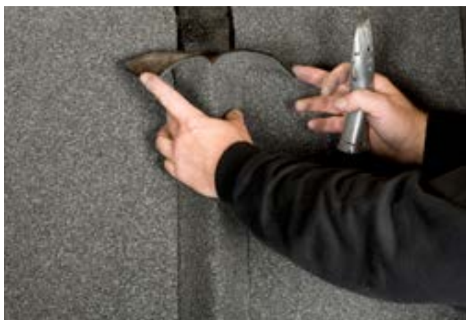
Figur 8.1.1.15: Tilskæring af kappe.
