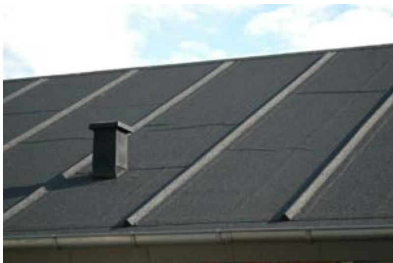
Figur 6.2.1: Eksempel på overpap med uacceptable folder.
