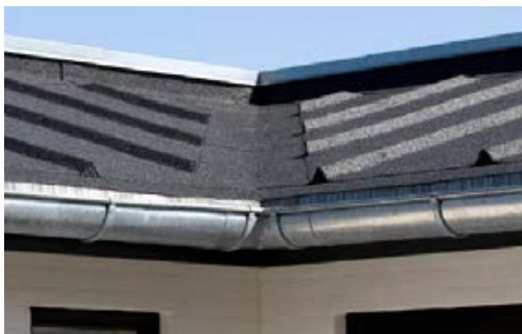
Figur 2.4.2: Skotrende mellem 2 tagflader med listedækning.
