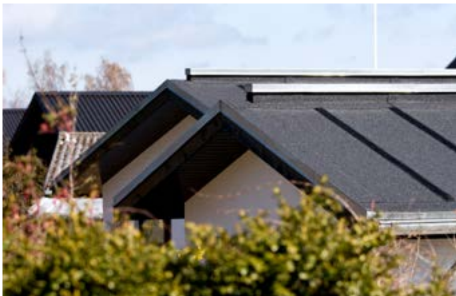
Renovering af 70'er hus Hundested.
