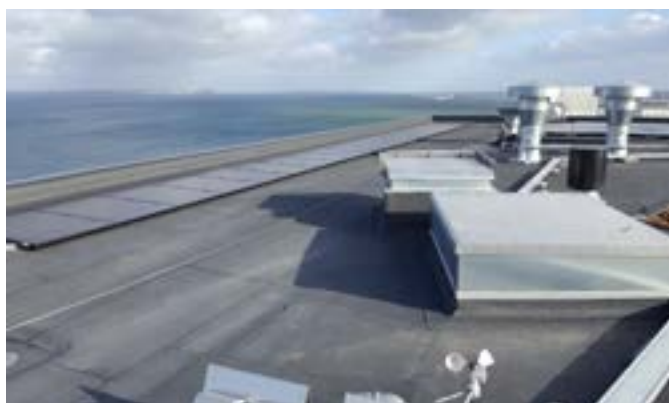
Figur 15.3.1: Placering af solcellepaneler i rand- og hjørnezoner af taget medfører ekstra vindlast.
