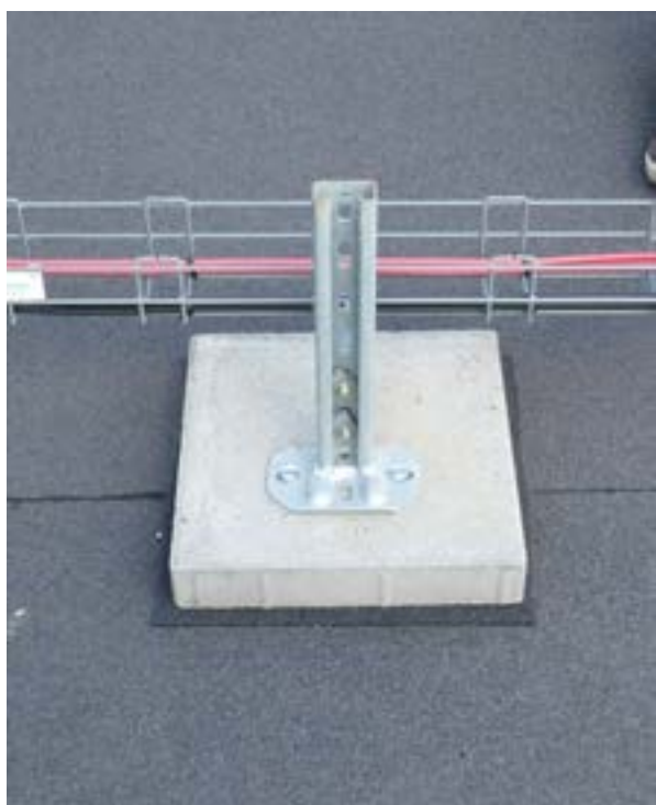
Figur 15.7.2: Beskyttelsespap under bæring for kabler.
