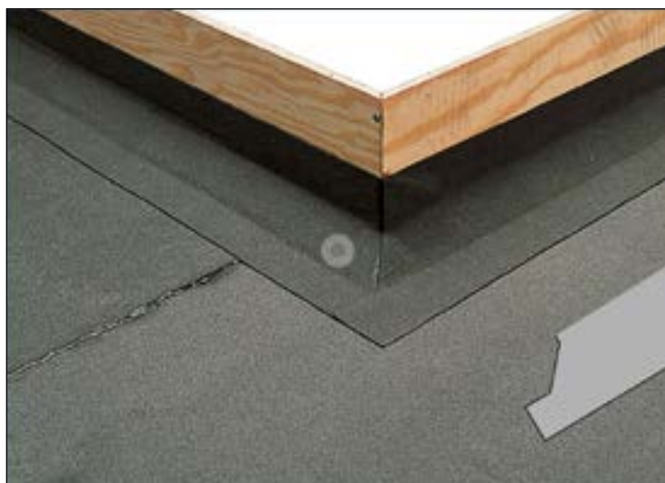
Figur 3.3.b: Udadgående hjørne. Anden understrimmel vist som principskitse.
