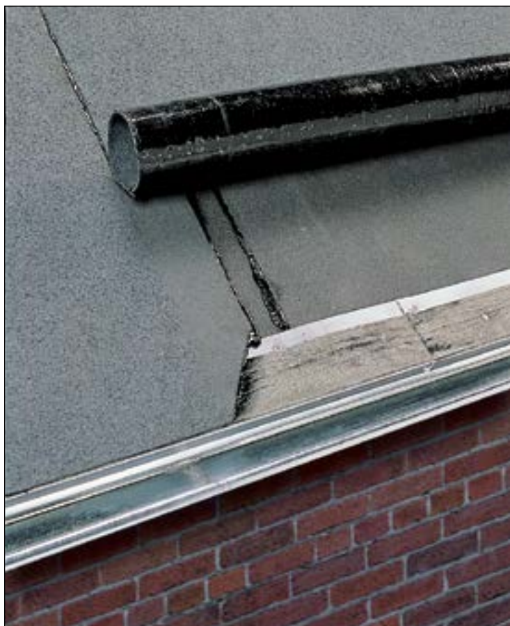
Figur 3.1: Hjørnet på overpappen snittes skråt af for at få en tæt og pæn afslutning.
