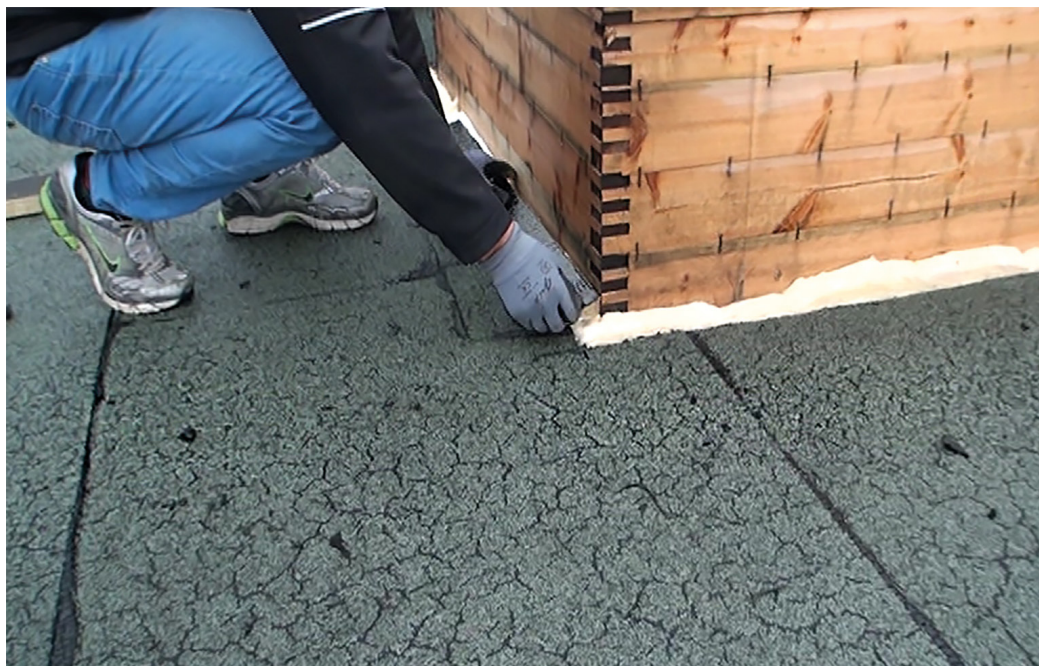
Foto 2: Lukning med brandfuge omkring ovenlys. Kilde: BYG-ERFA Brandteknisk lukning af spalter mod hulrum (37) 170604.
