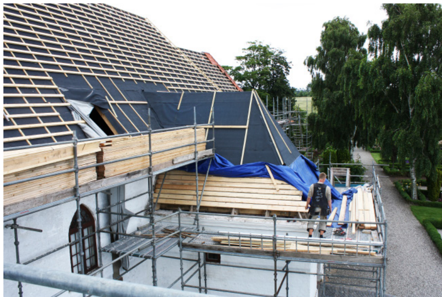
Figur 8.1 Fast undertag med afstandslist under lægtning
