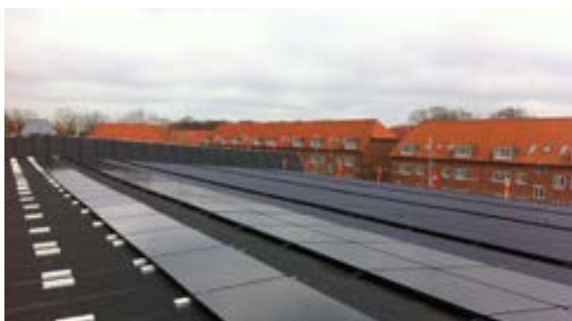
Figur 15.2.3.1 Eksempel på klæbet løsning, hvor skinnerne klæbes til tagdækningen.
